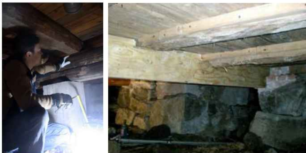
Oikea kuva: Lattiarakenteita voi parsia kuntoon myös alhaalta päin. Vasen kuva: vioittunut palkki on vaihdettu. [Lähteet: http://www.wix.com/maugenet/remontix#!referenssit/vstc2=sivu-5 ; http://varpanen.blogspot.com/2011_05_01_archive.html ]
